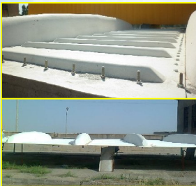
کاورینگ و ایزوله کردن سازه ایستگاه پمپاژ فاضلاب شماره ۱ شهر قم با کامپوزیت
