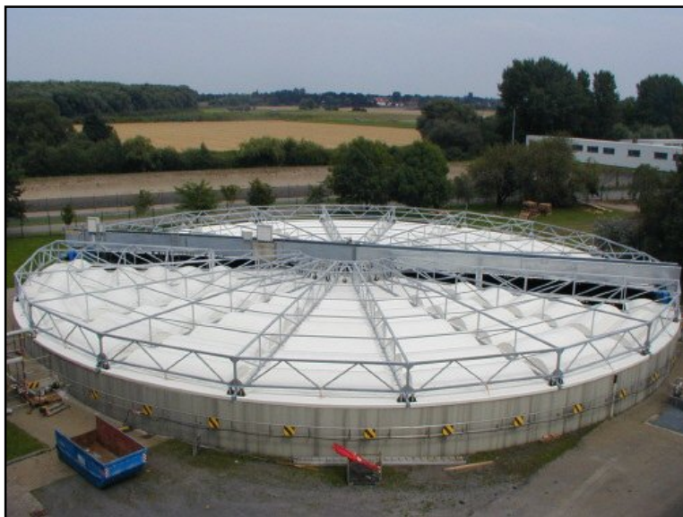
شکل شماره ۵- شمائی از پوشش کامپوزیتی (GRP Cover) حوض ته نشینی دایره ای
