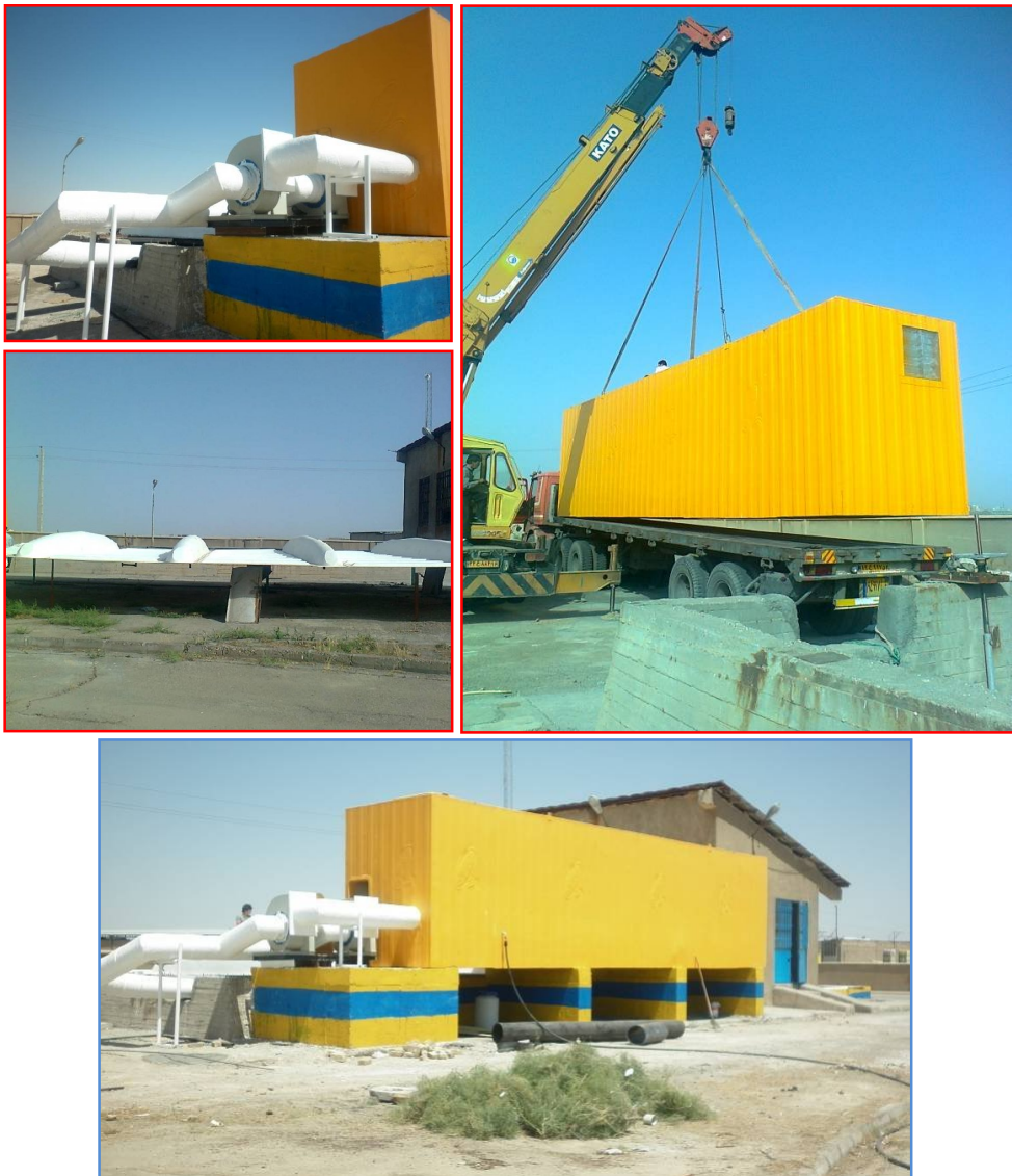
شکل شماره ۳- شمائی از سیستم تصفیه و حذف بو به روش بیولوژیکی در مقیاس بزرگ
