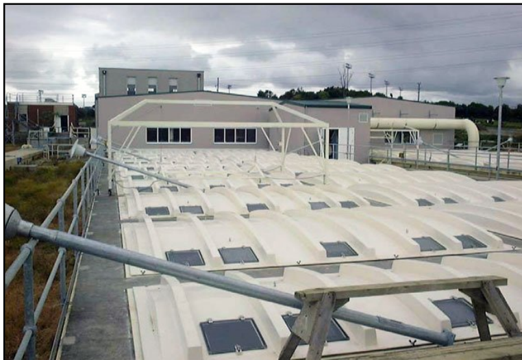
شکل شماره ۴- شمائی از پوشش کامپوزیتی (GRP Cover) تانک هوادهی فاضلاب
