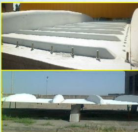
کاورینگ و ایزوله کردن سازه ایستگاه پمپاژ فاضلاب شماره ۱ شهر قم با کامپوزیت
